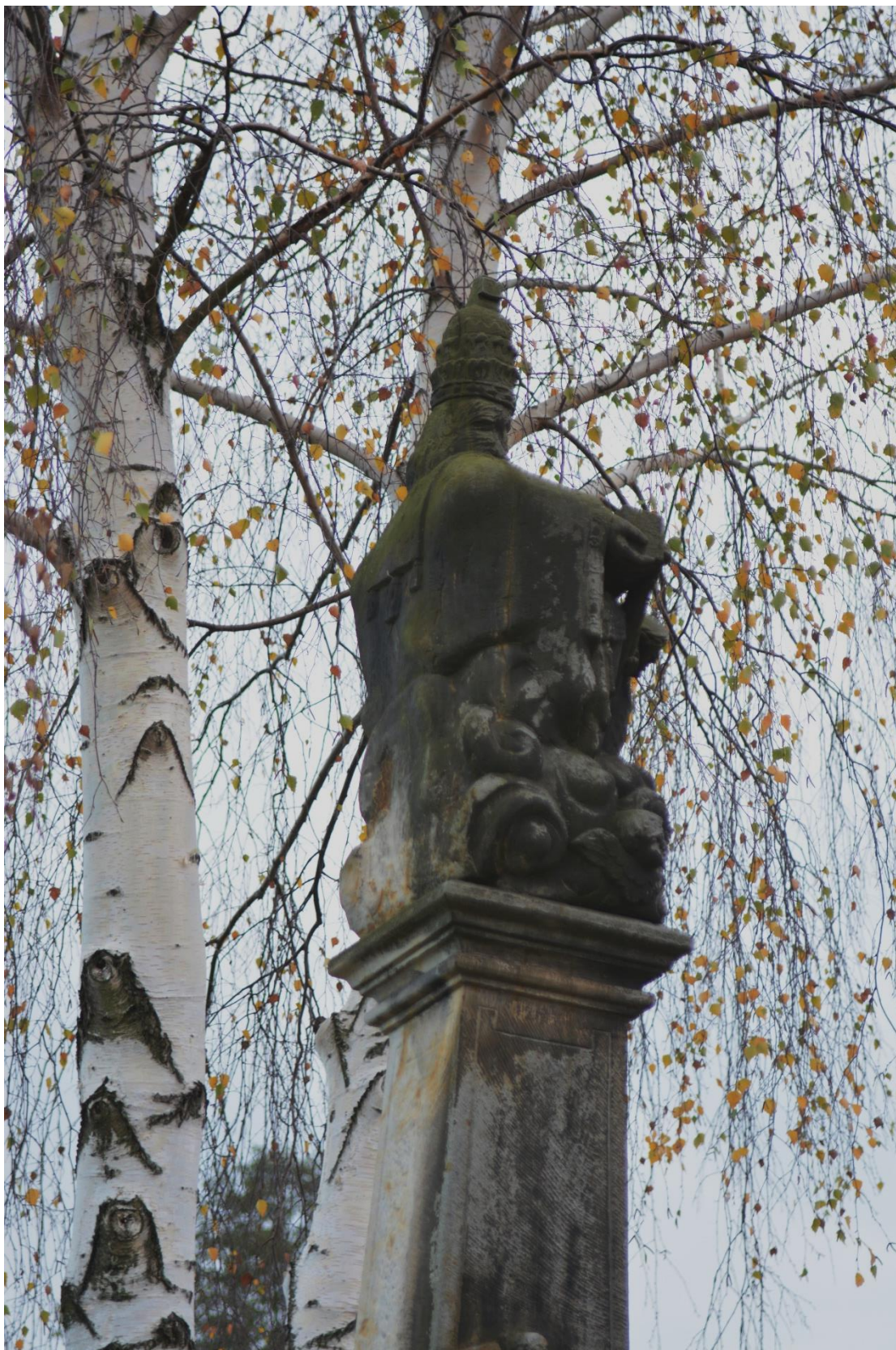
ROZSTÁNÍ, PILÍŘ SE SV. TROJICÍ, STAV PŘED RESTAUROVÁNÍM - PILÍŘ S PODSTAVCEM OSOVĚ VYCHÝLEN, NESTABILNÍ OBJEKT, HROZÍ ZŘÍČENÍ
