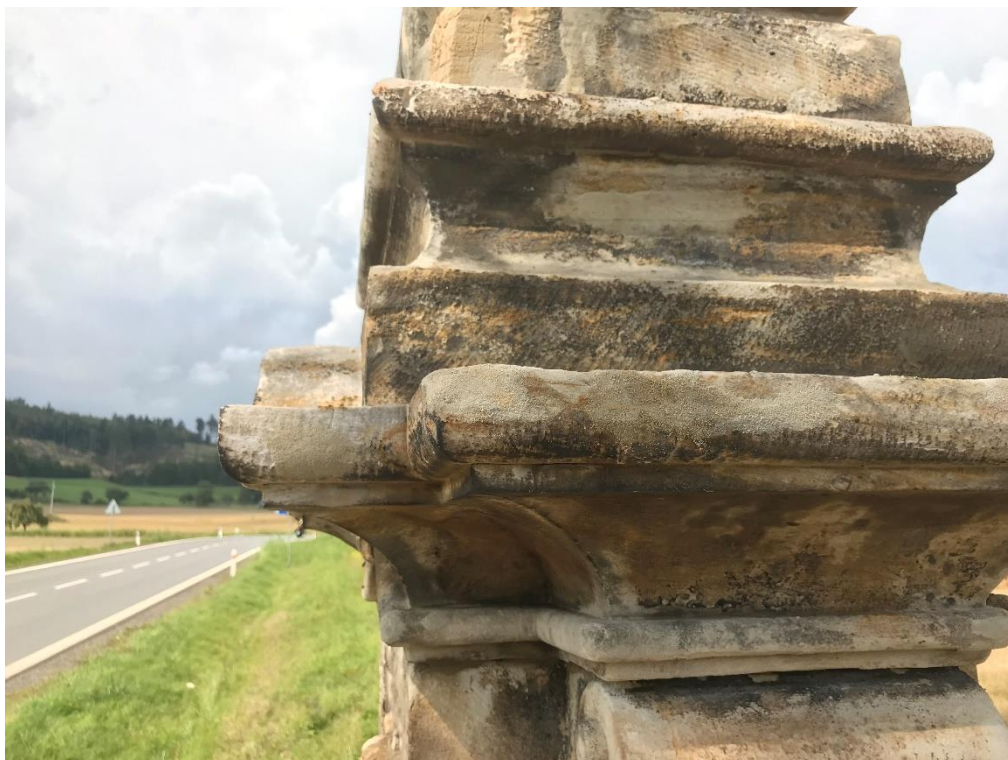
ROZSTÁNÍ, PILÍŘ SE SV. TROJICÍ, STAV PO OČIŠTĚNÍ, POSTUP TMELENÍ ARCHITEKTURY
