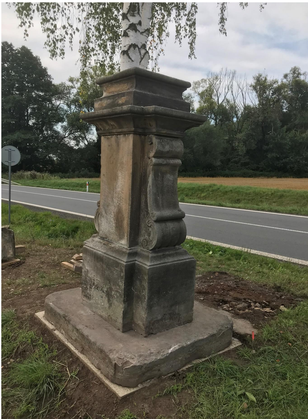
ROZSTÁNÍ, PILÍŘ SE SV. TROJICÍ, STAV PŘED RESTAUROVÁNÍM – OSAZOVÁNÍ NA NOVÝ ZÁKLAD
