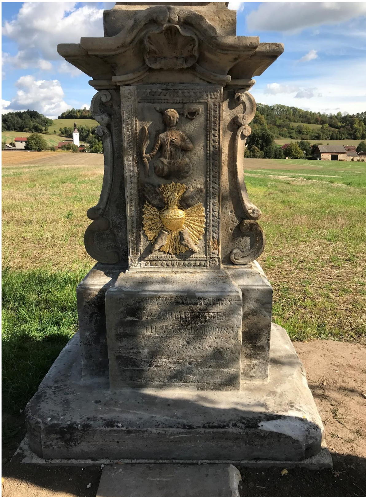
ROZSTÁNÍ, PILÍŘ SE SV. TROJICÍ, STAV PO RESTAUROVÁNÍ
