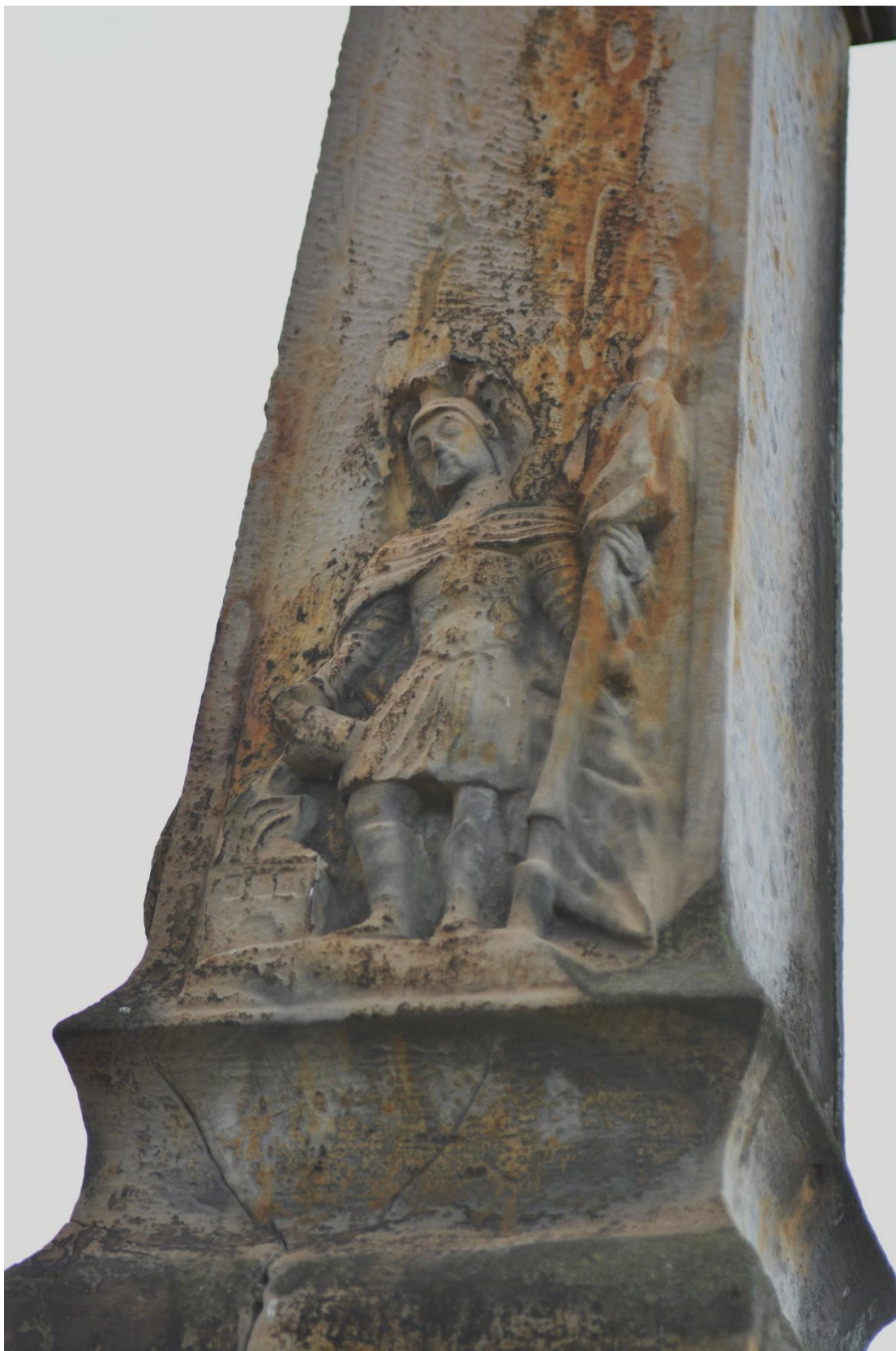
ROZSTÁNÍ, PILÍŘ SE SV. TROJICÍ, STAV PŘED RESTAUROVÁNÍM – STATICKÉ TRHLINY V KAMENI
