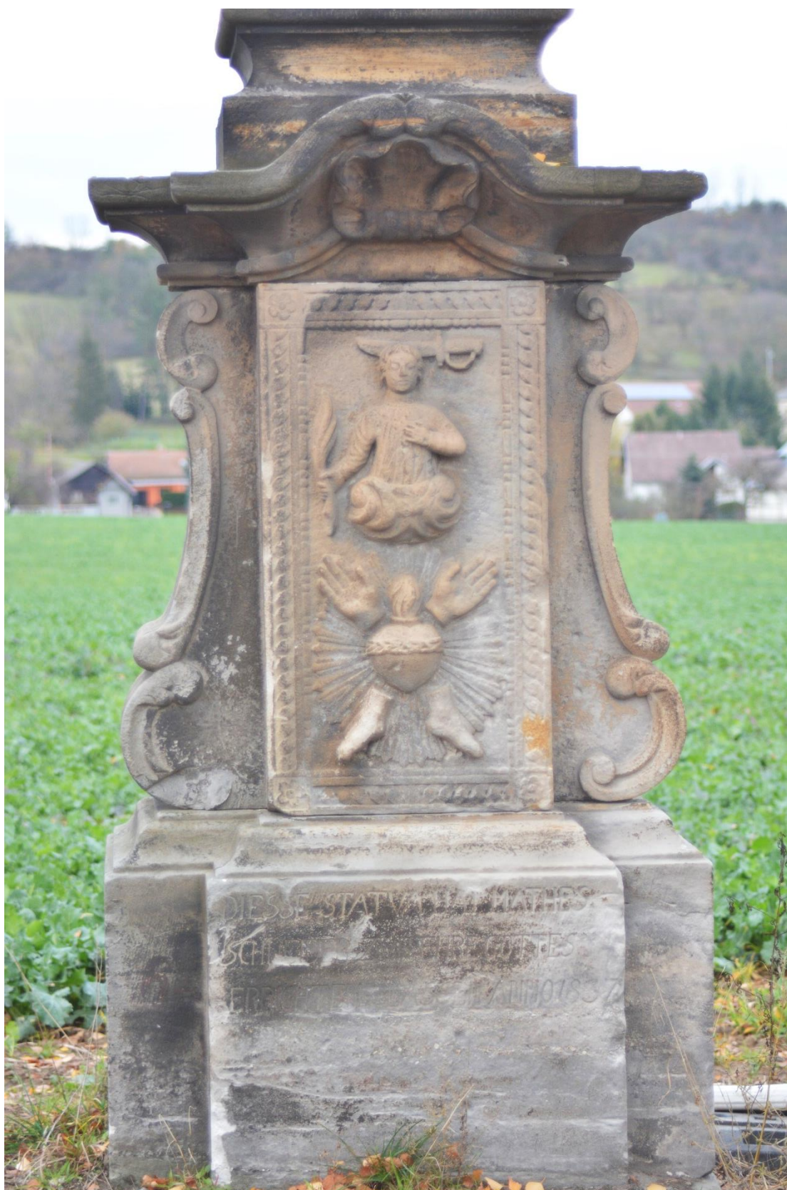
ROZSTÁNÍ, PILÍŘ SE SV. TROJICÍ, STAV PŘED RESTAUROVÁNÍM – ZNEČIŠTĚNÍ KAMENE, CHYBĚJÍCÍ MODELACE ARCHITEKTURY
