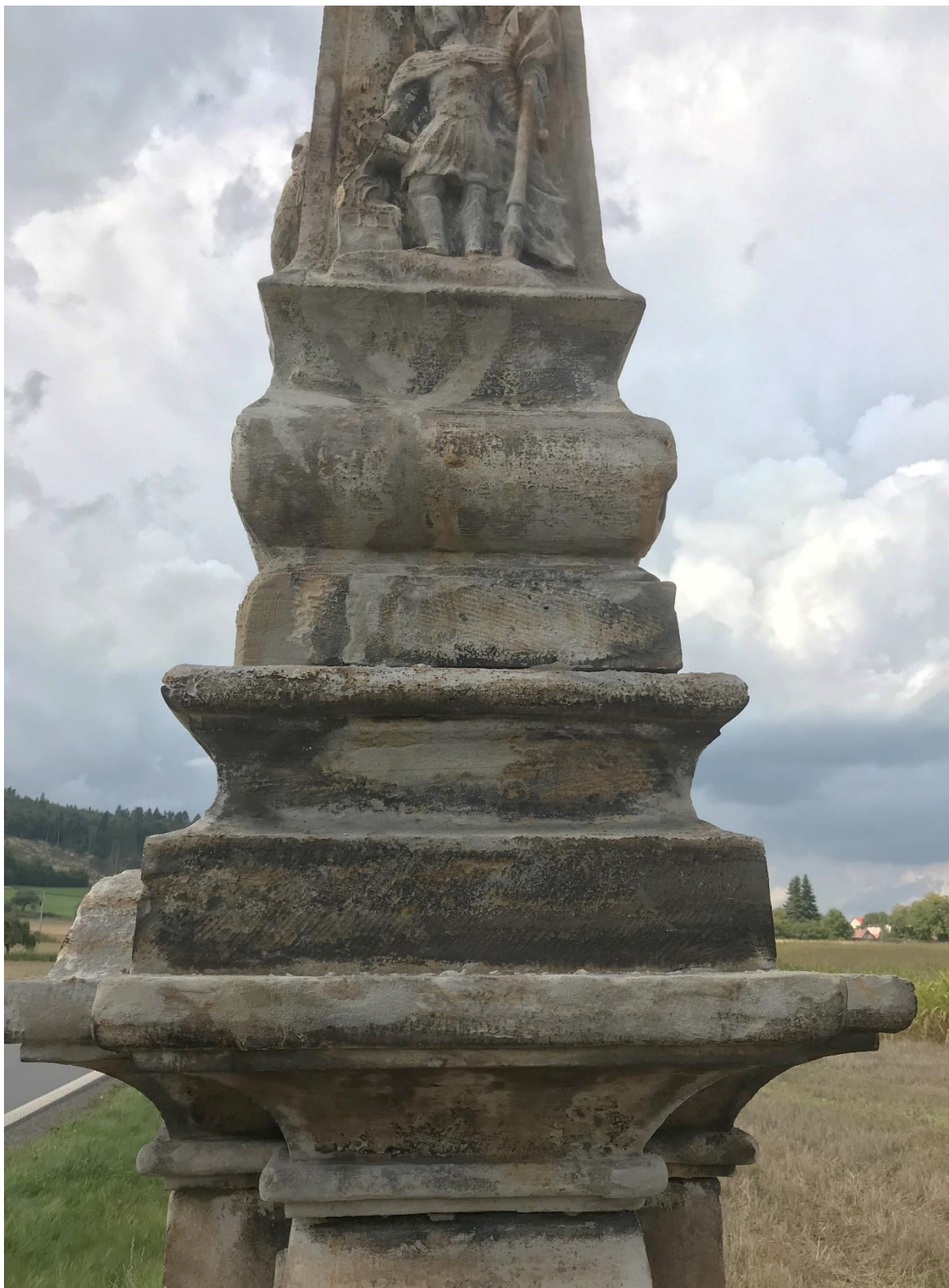
ROZSTÁNÍ, PILÍŘ SE SV. TROJICÍ, STAV PO OČIŠTĚNÍ, STATICKÉ ZPEVNĚNÍ, VYSPRÁVKY A TMELY
