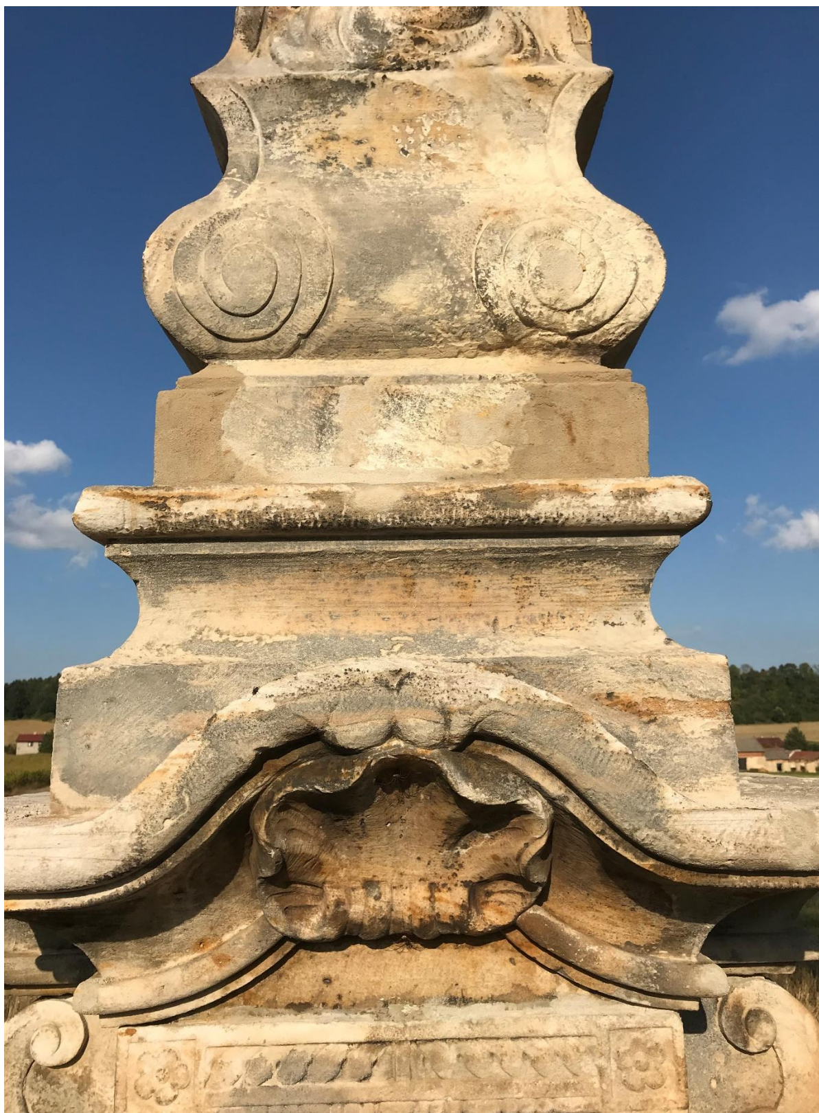
ROZSTÁNÍ, PILÍŘ SE SV. TROJICÍ, STAV PO OČIŠTĚNÍ, POSTUP TMELENÍ ARCHITEKTURY
