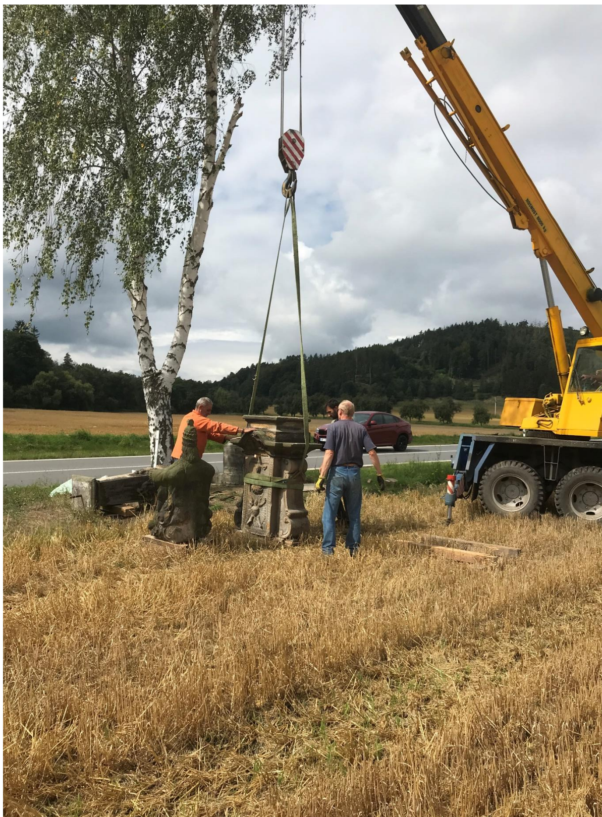
ROZSTÁNÍ, PILÍŘ SE SV. TROJICÍ, STAV PŘED RESTAUROVÁNÍM – ROZEBÍRÁNÍ
