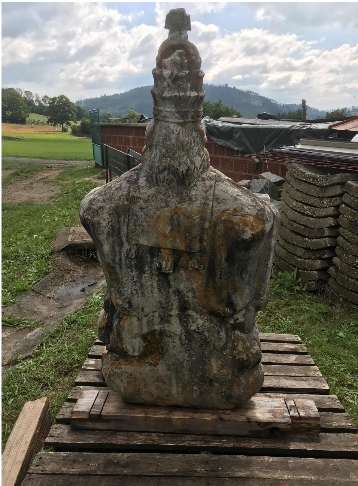
ROZSTÁNÍ, PILÍŘ SE SV. TROJICÍ, STAV PŘED OČIŠTĚNÍM
