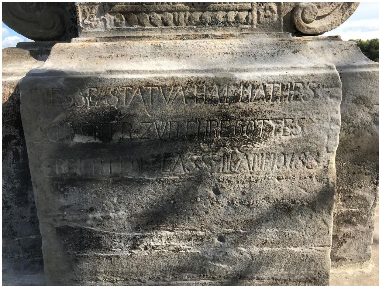
ROZSTÁNÍ, PILÍŘ SE SV. TROJICÍ, STAV PO RESTAUROVÁNÍ
