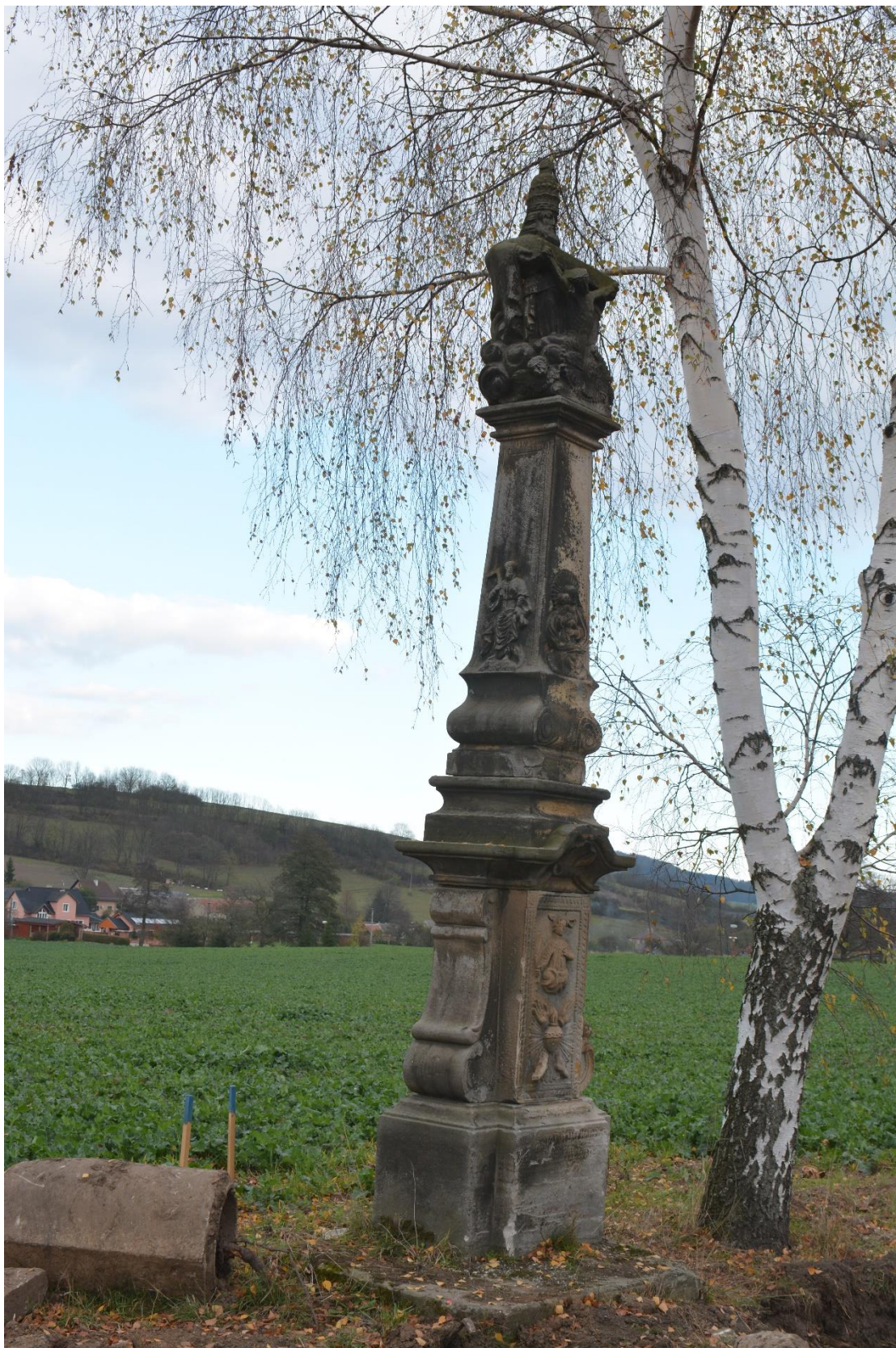
ROZSTÁNÍ, PILÍŘ SE SV. TROJICÍ, STAV PŘED RESTAUROVÁNÍM - PILÍŘ S PODSTAVCEM OSOVĚ VYCHÝLEN, NESTABILNÍ OBJEKT, HROZÍ ZŘÍCENÍ
