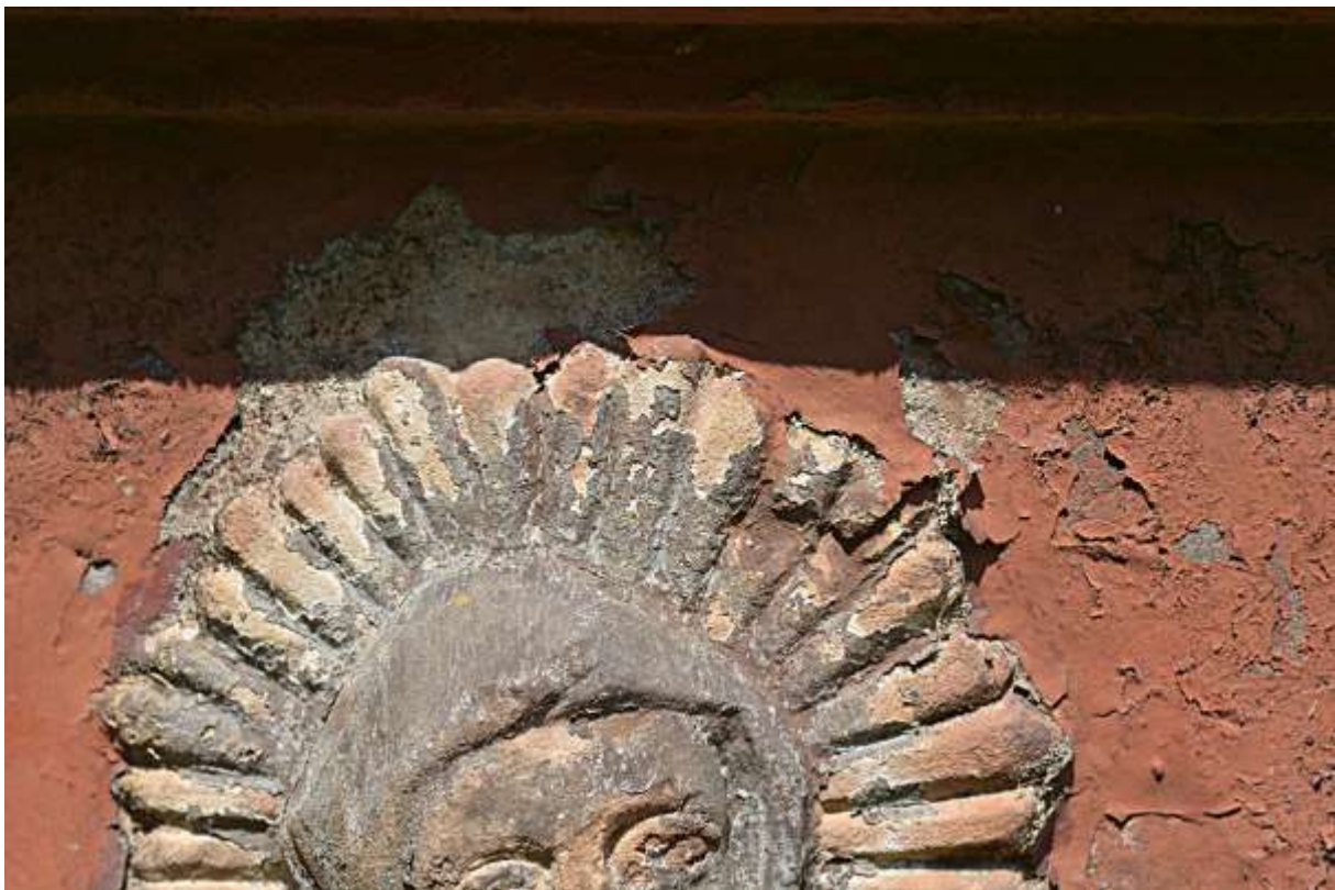
Rozstání, kříž na p.č.572/2, zvětralá hornina pod nevhodnými druhotnými nátěry
