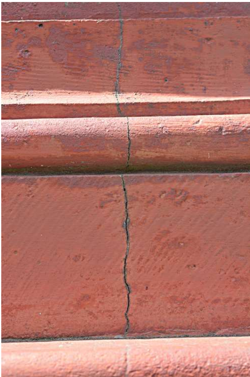
Rozstání, kříž na p.č.572/2, horizontální statická prasklina v podstavci
