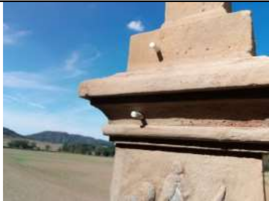
SLEPENÍ PRASKLIN SKLOLAMINÁTOVÝMI TYČEMI
