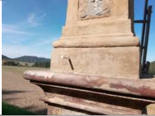
SLEPENÍ PRASKLIN SKLOLAMINÁTOVÝMI TYČEMI
