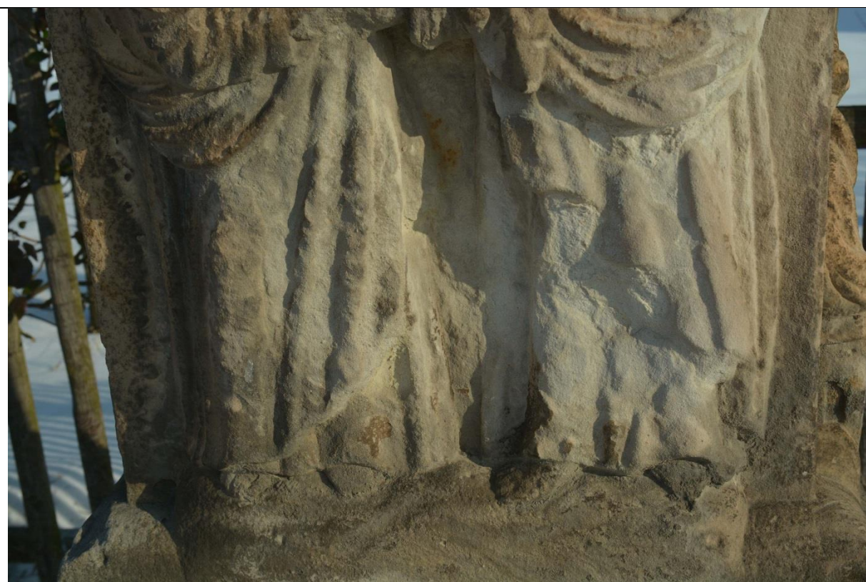
ROZSTÁNÍ - SOUSOŠÍ NEJSVĚTĚJŠÍ TROJICE, parc.číslo 169/2 ZVĚTRALÝ KÁMEN, CHYBĚJÍCÍ HMOTA
