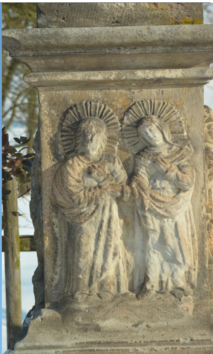
ROZSTÁNÍ - SOUSOŠÍ NEJSVĚTĚJŠÍ TROJICE, parc.číslo 169/2 ZVĚTRALÝ KÁMEN, CHYBĚJÍCÍ HMOTA
