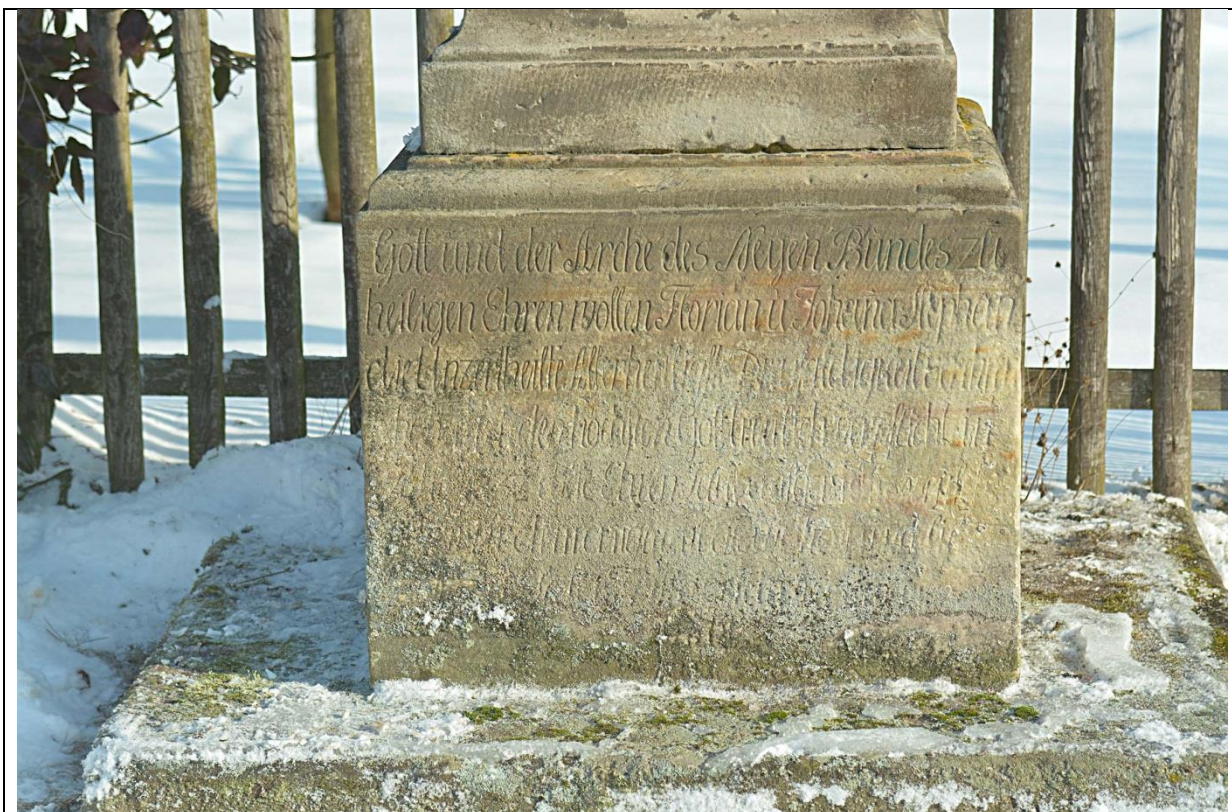
ROZSTÁNÍ - SOUSOŠÍ NEJSVĚTĚJŠÍ TROJICE, parc.číslo 169/2 ZASOLENÍ SPODNÍ ČÁSTI PODSTAVCE
