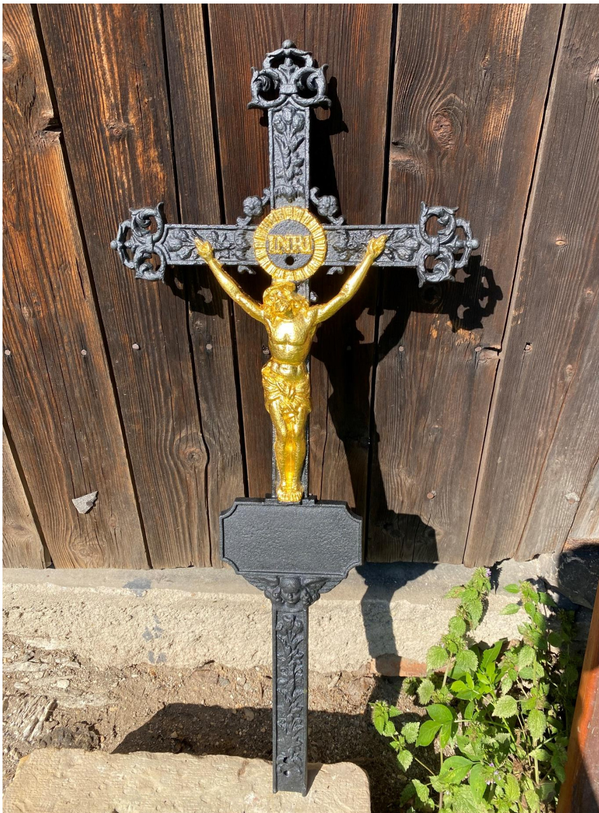
ROZSTÁNÍ – KŘÍŽ U SILNICE 371, STAV PO RESTAUROVÁNÍ LITINOVÉHO KŘÍŽE, ZLACENÍ, OŠETŘENÍ POVRCHU KONZERVAČNÍM NÁTĚREM NA LITINU
