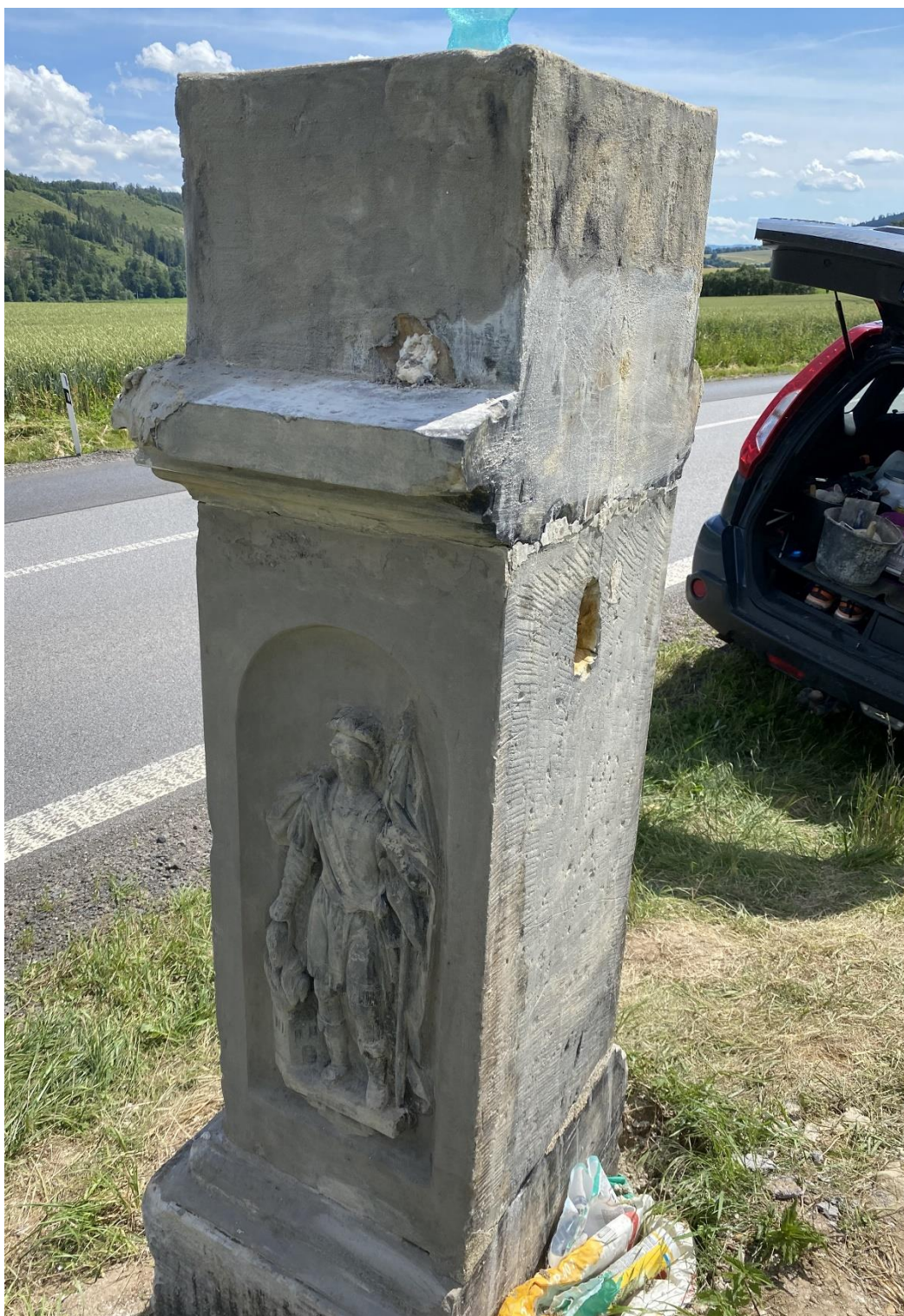
ROZSTÁNÍ – KŘÍŽ U SILNICE 371, STAV PO OČIŠTĚNÍ, DOPLŇOVÁNÍ HORNÍ ČÁSTI UMĚLÝM KAMENEM, ZPEVNĚNÍ PRASKLÉ HMOTY
