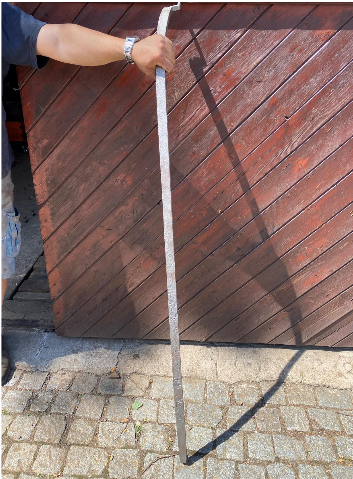
ROZSTÁNÍ – KŘÍŽ U SILNICE 371, STAV PO OČIŠTĚNÍ ZPEVŇOVACÍHO TÁHLA LITINOVÉHO KŘÍŽE, ZJIŠTĚNÉ DETAILY – VROČENÍ, PODPIS PROVÁDĚJÍCÍHO KOVÁŘE, VYRAŽENÉ KOVÁŘSKÉ ZNAČKY A ZDOBENÍ
